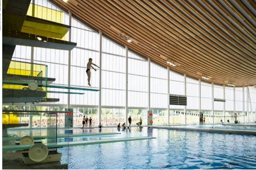
A Kingspan Isoeste lança seu primeiro painel de parede translúcido que permite entrada de luz natural aos ambientes. O produto oferece conforto térmico quatro vezes superior a sistemas construtivos tradicionais e película UV que previne o amarelamento.
